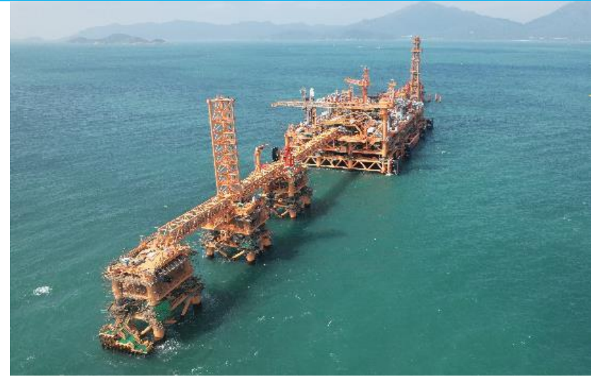
雙泊位碼頭的施工情況
