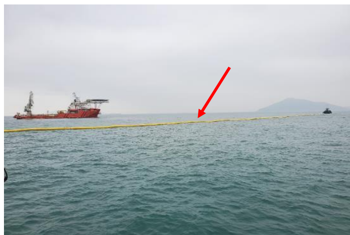
漂浮式淤泥屏障 (約600米長)
