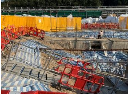
使用不透水的帆布覆蓋臨時儲存物料
