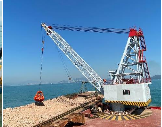
在已完成沖噴的管道上鋪上石塊保護層
