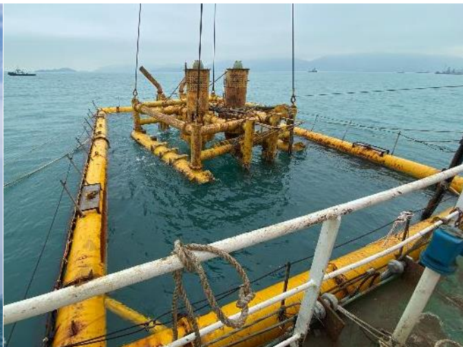
已安裝的籠式淤泥屏障
