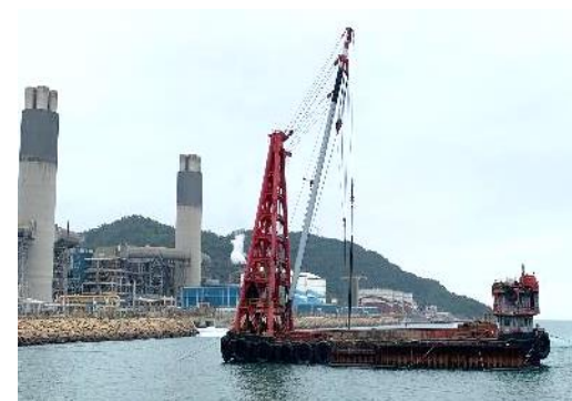
圍堰移除工程
