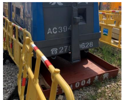
化學廢料儲漏盤
