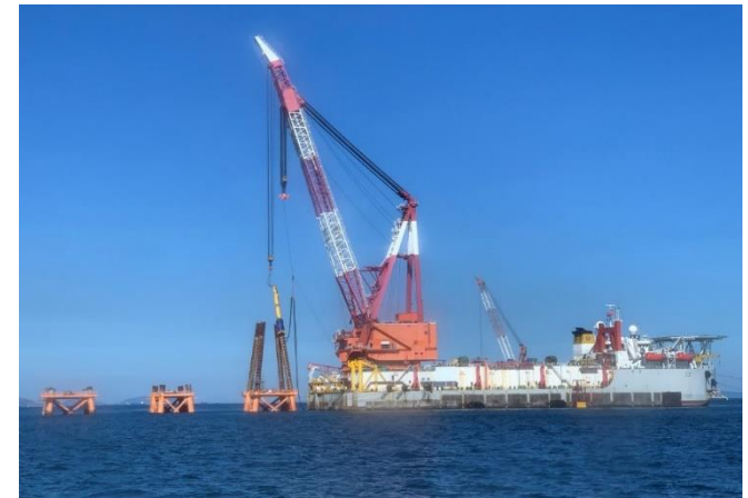
海上液化天然氣接收站的施工情況
