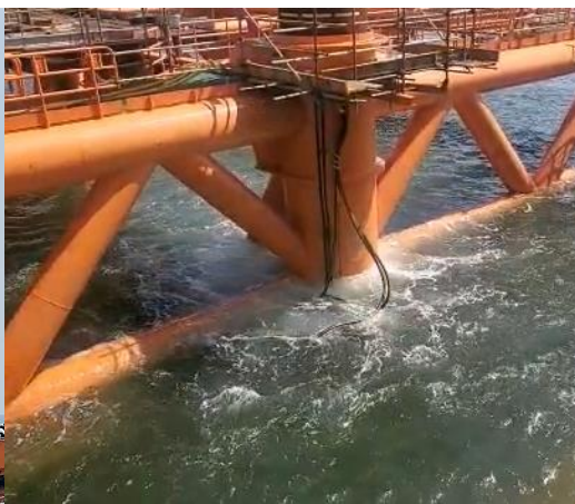
氣泡幕簾 將打樁工程圍封， 以減低水底聲音的傳播
