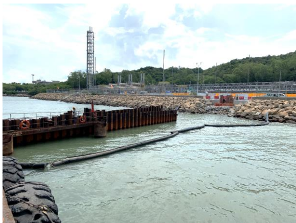
設置圍堰及淤泥屏障減低挖泥對水質的影響
