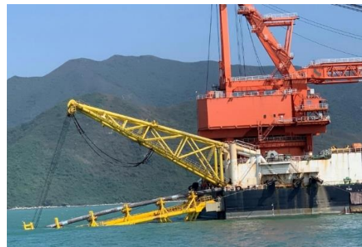
鋪設管道工程
