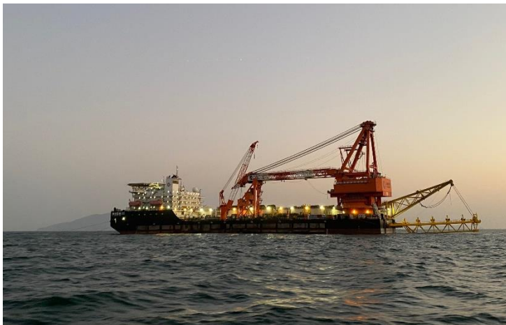
鋪設海底氣體管道的工程船
