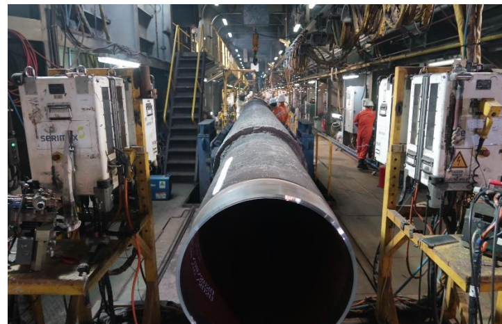
海底氣體管道直徑為20吋
