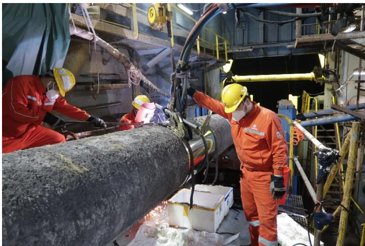
工程人員為海底氣體管道進行加工
