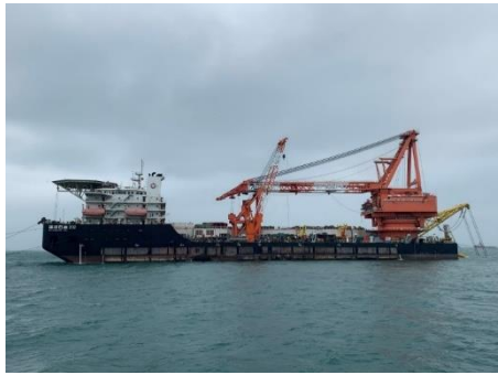
鋪設海底氣體管道
