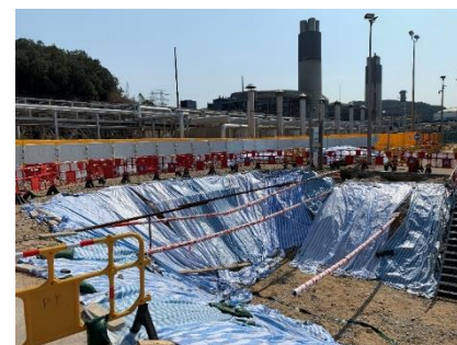
使用不透水的帆布覆蓋臨時 儲存的物料
