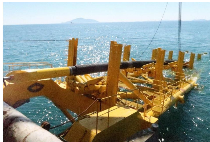
海底氣體管道沿著走線鋪設到海床
